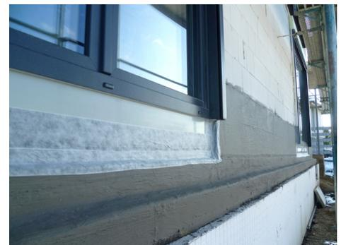
Anschluss eines bodentiefen Fensters im Übergang zur Sockelabdichtung mit PCI Barraseal Turbo.
