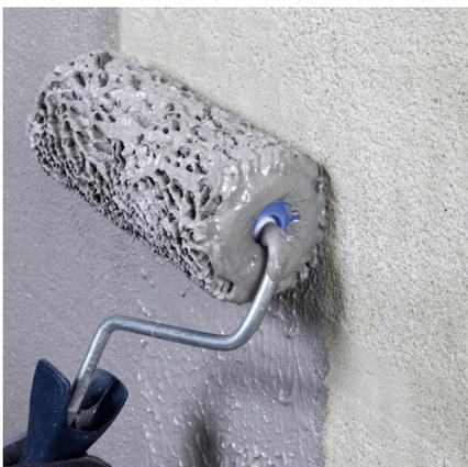
Aufbringen einer Kontaktschicht mit dem Roller.
