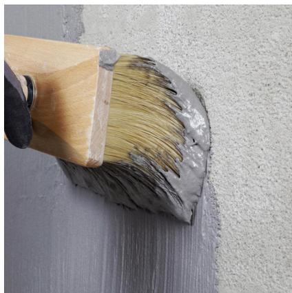
Aufbringen einer Kontaktschicht mittels Bürste oder Quast.
