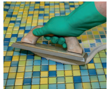
Mit PCI Durapox NT und PCI Durapox NT plus können Mosaikbeläge chemikalienbeständig und wasserundurchlässig verfugt werden.
