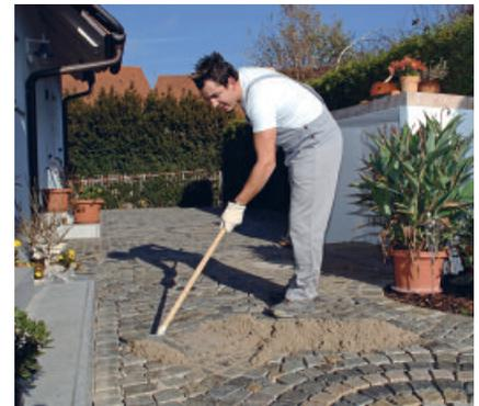
Der 2-komponentige Pflasterfugenmörtel PCI Pavifix PU ist wasserdurchlässig und verhindert somit eine vollständige Versiegelung der Flächen. Regenwasser kann schnell in den Untergrund abfließen.
