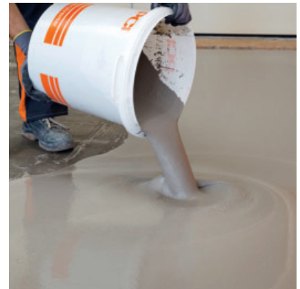
Rationeller und wirtschaftlicher Bodenausgleich mit PCI Periplan vor dem Verlegen von Oberbelägen.
