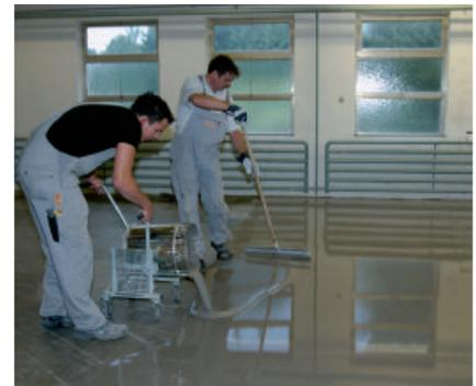
Der extrem leichte Verlauf von PCI Periplan® fein ermöglicht stehende Verarbeitung mit der Rakel für rationellen und planebenen Bodenausgleich.
