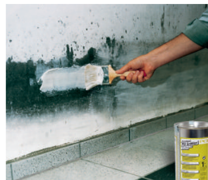
Auftragen von PCI Entöler-Paste auf einen verölten Untergrund, hier auf einen verölten Wandbereich aufgrund eines Hochwasserschadens.
