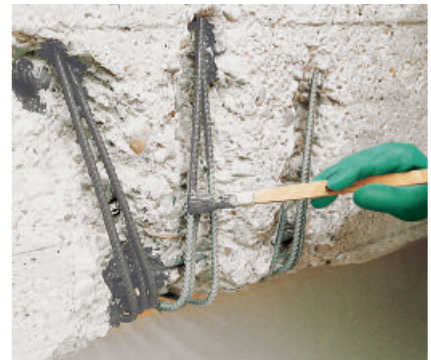
Der mineralische Korrosionsschutz nach ZTV-ING PCI Legaran RP bildet einen dauerhaften Schutz gegen die korrosionsfördernde Wirkung von Tausalz und carbonatisiertem Beton.
