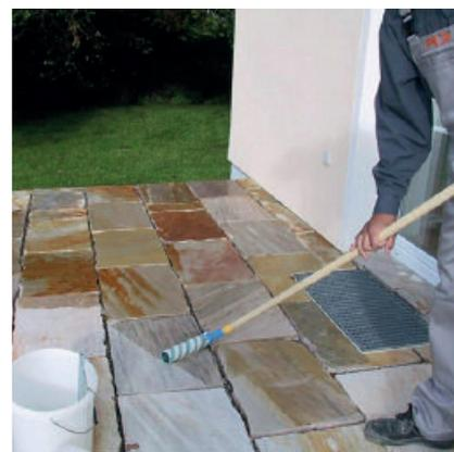
Das Aufbringen von PCI Pavifix V vor dem Verfugen erleichtert das anschließende Entfernen von Rückständen auf der Steinoberfläche und erhält die natürliche Optik des Natursteins.
