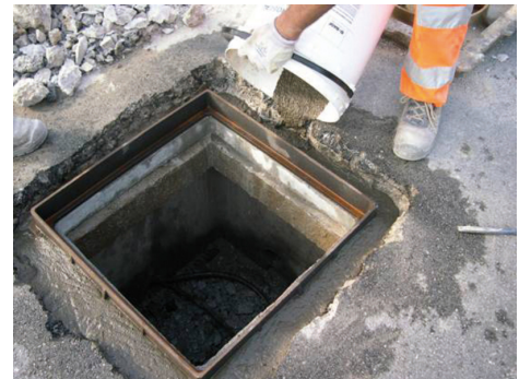
Ausgossen eines Kanalschachtrahmens mit PCI Repafast Fluid.
