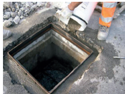
Ausgossen eines Kanalschachtrahmens mit PCI Repafast Fluid.
