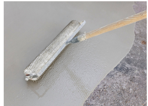
Auf der klebefreien, ausgehärteten Grundierung ausgegossenes und verteiltes PCI Zemtec 1K während des Einbaus mit einer Stachelwalze egalisieren und entlüften.
