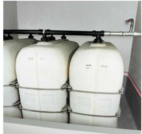
Heizöllagerraum mit PCI Visconal-Schutzbeschichtung.
