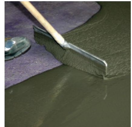
Danach wird PCI Zemtec® 180 mit einer Stiftrakel oder Schwabbelstange verteilt.
