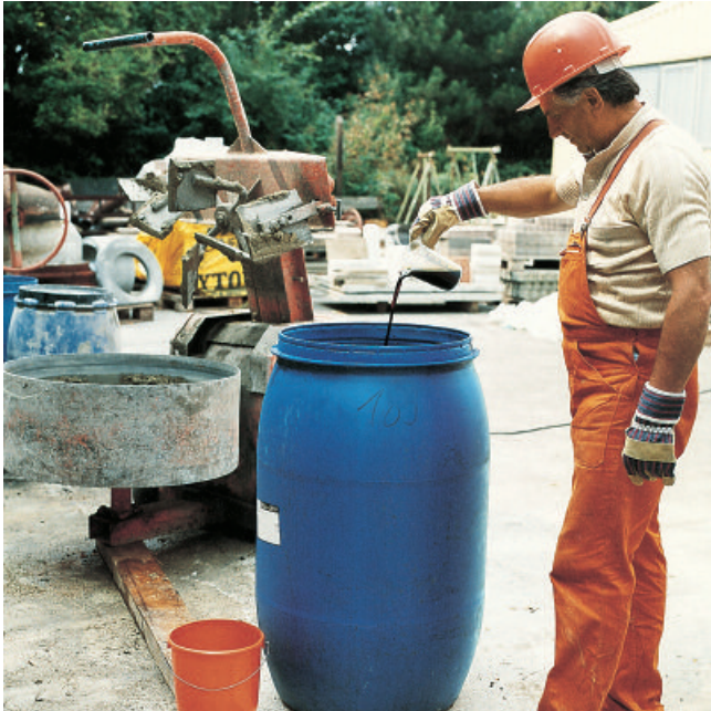
PCI Mischöl wird dem Anmachwasser für Mörtel beigemischt.
