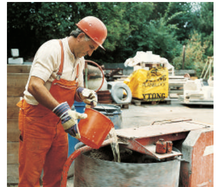
PCI Mischöl ist ein Luftporen bildendes Zusatzmittel für Mörtel, Putz und Estrich.
