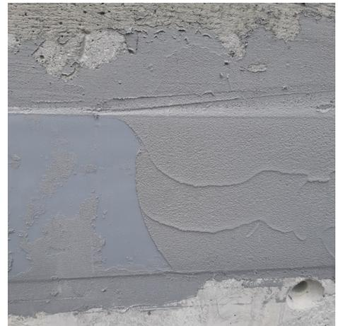
Verklebung von PCI Pectape 3000 - Abdichtungsband mit PCI Barrafix EP Fein während Überbeschichtung und vor Glätten.
