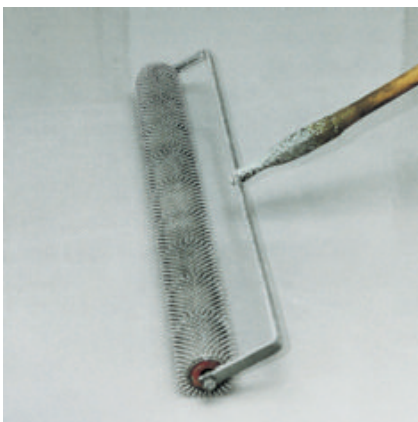
Zur Entlüftung und Egalisierung wird die frisch aufgebraute Beschichtung mit einer Stachelwalze überrollt.
