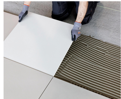
Verlegen von Feinsteinzeugplatten.
