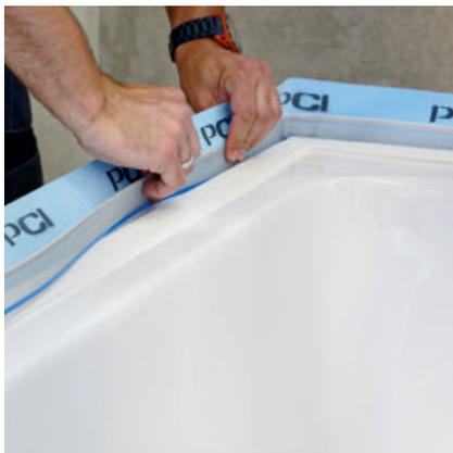
PCI Pecitape® Protect wird sicher in die Tasche von PCI Pecitape® WDB integriert.
