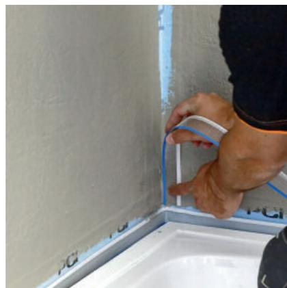
Fixieren von PCI Pecitape® Protect an der Wand mit Hilfe des Selbstklebestreifens.
