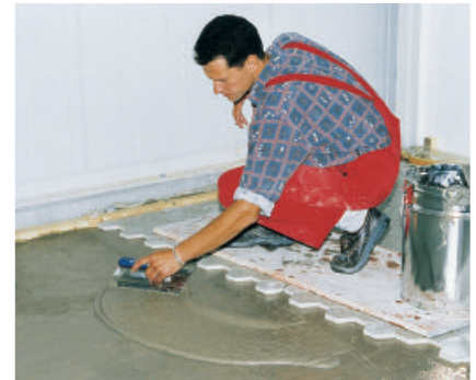
Der ausgegossene Verlegemörtel kann mit einer Zahnkelle leicht verteilt werden.
