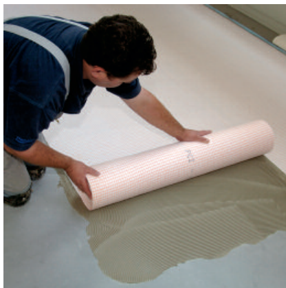
werden die PCI Pecilastic-Bahnen eingelegt...
