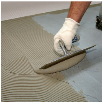
In das frisch aufgekämmte Kleberbett...
