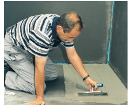
Mit PCI Lastoflex abgemischte PCI-Dünn- und Mittelbettmörtel bauen Untergrundspannungen ab und gleichen Spannungen infolge von Temperaturschwankungen aus.
