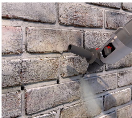
1. Bohren und anschließend Bohrloch ausblasen.
