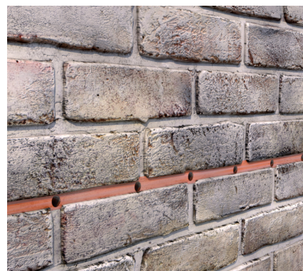
3. Verfilmte Horizontalsperre aus PCI Barra Creme.
