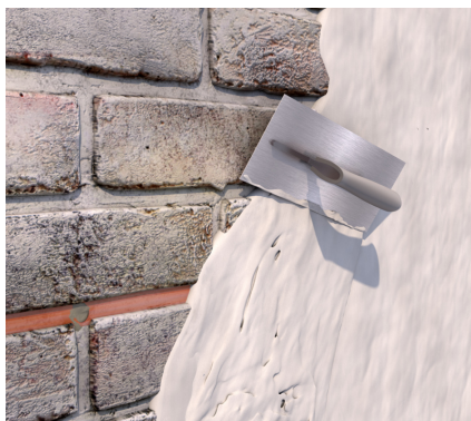
5. Überarbeiten des Mauerwerks mit PCI Saniment 2 in 1.
