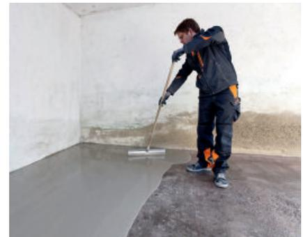
Vollflächiger Bodenausgleich mit leicht verlaufendem PCI Zemtec<sup>®</sup> 1K für direkte Nutzbarkeit.
