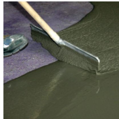
Danach wird PCI Zemtec® 180 mit einer Stiftrakel oder Schwabbelstange verteilt.
