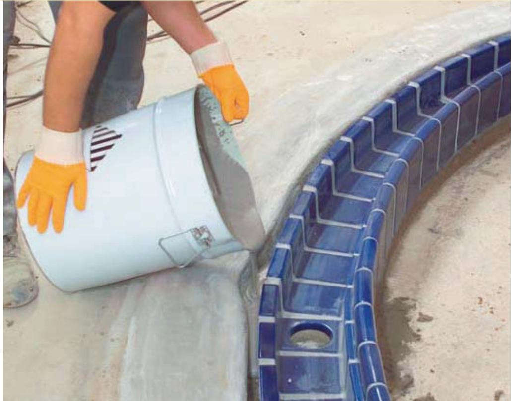
Damit im Beckenumgangsbereich Schäden in Form von Unterwanderungen unterhalb der Wasseroberfläche dauerhaft verhindert werden, wird PCI Apoten als kapillARBrechender Vergussmörtel eingesetzt.
