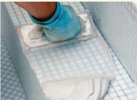
Verfugen des Wand- und Bodenbelags mit dem hoch verschleißfesten Reaktionsmörtel PCI Durapox NT/NT plus.
