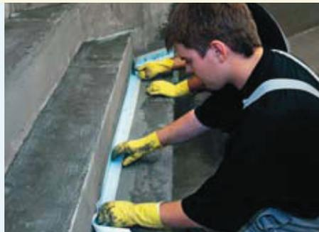
Einlegen von PCI Pectitape 120 in die frische PCI Seccoral-Abdichtung.
