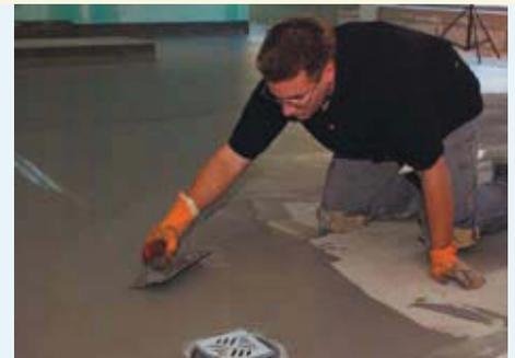
Aufbringen der Sicherheits-Dichtschlämme PCI Seccoral als Grundierung auf den bereits vorgewässerten Untergrund. Nach dem Durchtrocknen sind mindestens zwei Aufträge im Spachtelverfahren erforderlich.
