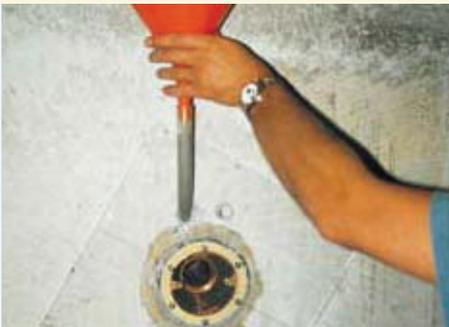
Verguss einer nicht wasserdichten bzw. nachträglich eingebauten Einströmdüse mit PCI Apoten.
