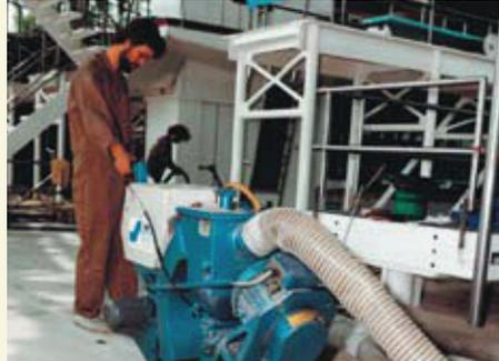
Staubfreie Untergrundvorbehandlung im Bodenbereich durch Stahlkugelstrahlen.
