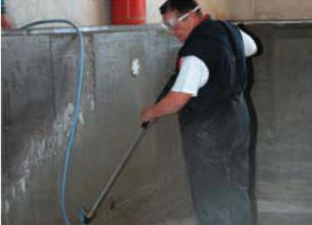
Untergrundvorbehandlung des Betonkörpers mit Hochdruckreiniger oder durch Sandstrahlen.
