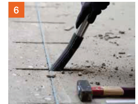
6 ...und lose Estrichreste mittels Industriestaubsauger abgesaugt.
