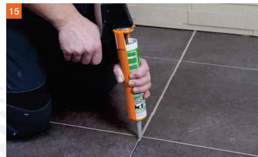
15 Nach dem Verfugen der Bodenfläche mit PCI Nanofug® Premium erfolgt die Versiegelung der an die Trennfuge angrenzenden Belagsfuge mit PCI Silcofug® E. Diese muss nicht breiter als die übrigen Belagsfugen ausgeführt werden und fügt sich so harmonisch in das Fugenbild ein.
