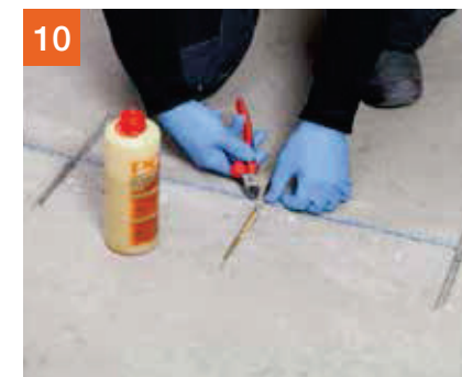
10 ...den PCI Apogel® Dübel in die Nut einlegen und den Spannring entfernen...
