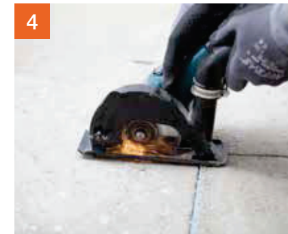
4 Anschließend werden diese Bereiche mittels Trennschleifer eingeschnitten....
