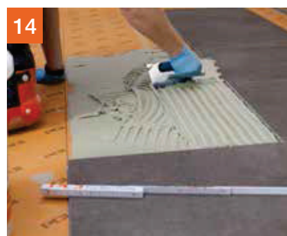
14 Auch die Verlegung der Bodenfliesen erfolgt mit PCI Flexmörtel® S2.
