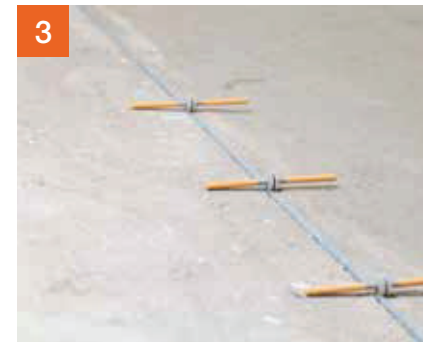
3 ...diese werden im Abstand von 20 bis 30 cm positioniert.
