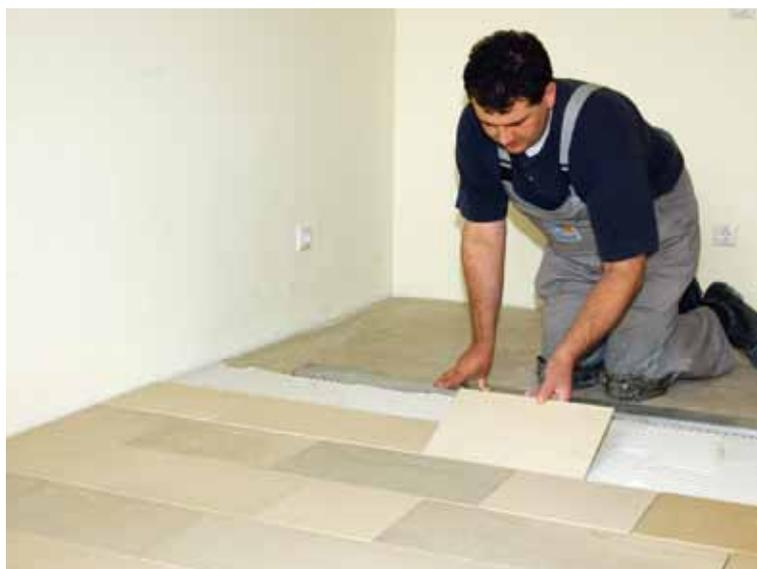
Verkleben von Solnhofener Platten auf Heizstrich mit PCI Carralight
