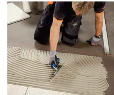
PCI Flexmörtel® S2/S2 Rapid Kleberbett aufziehen
