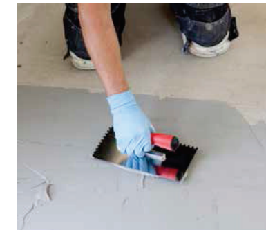
Abdichtung mit PCI Seccoral® 2K Rapid
