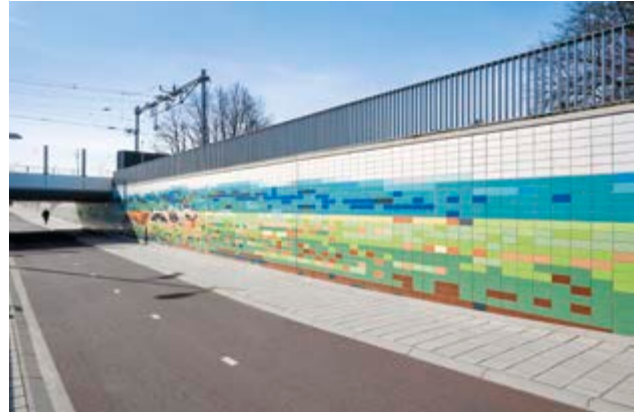
Wirkt, wo besonders viele Schadstoffe entstehen Fedor van Kregtentunnel, Niederlande / Architekt: Royal Haskoning DHV, Herr Mari Baauw / Foto: Marcel van der Burg
