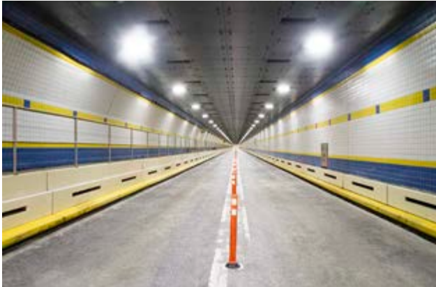
Reinigt die Luft auch in Tunneln Hugh L. Carey Tunnel, New York, USA / Architekt: HAKS, New York / Foto: Titus Kana
