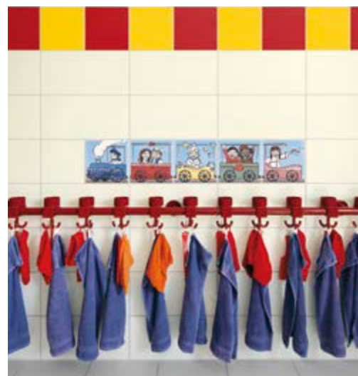
Stark in Kita und Schulen KiTa Zwergenland, Gräfenroda, Deutschland / Architekt: Steinbacher-Consult GmbH / Foto: Claus Graubner
