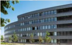
■ Bürogebäude Sky, Unterföhring, Deutschland
