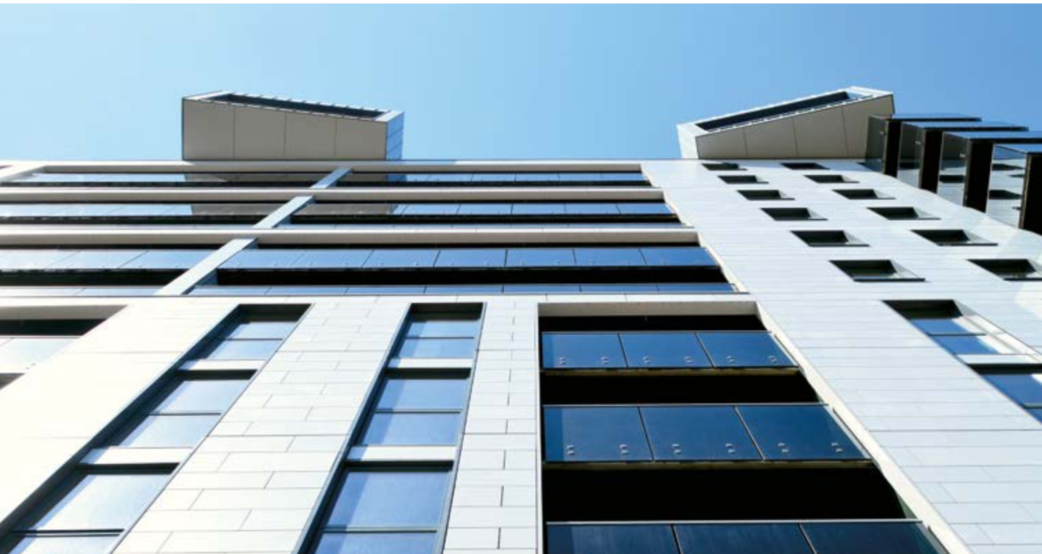
Thurston Road, London, Großbritannien / Architekt: ECE Architecture / Jahr: 2015 / Foto: Alice Jenner
