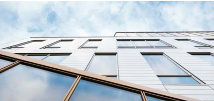
Ordre des infirmières et infirmiers du Québec, Kanada / Architekt: Lemay architecte / Jahr: 2015 / Foto: Adrien Williams
