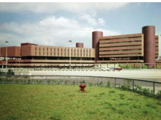
Polytechnikum, Hongkong, China / Architekt: Messrs. Palmer & Turner
