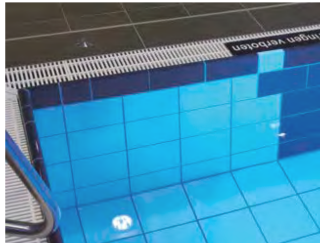
Krandelbad, Wildeshausen, Deutschland · Germany Architekt · Architect: janßen bär partnerschaft mbB, Bad Zwischenahn, Deutschland · Germany · Photo: Jochen Stüber
