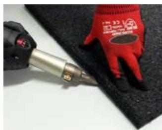
Befestigung mit der Dachbahn im **Heißluftschweißverfahren**
