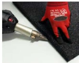
Befestigung mit der Dachbahn im **Heißluftschweißverfahren**
