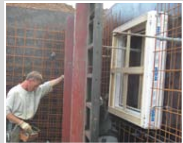
Innere Schalung stellen
