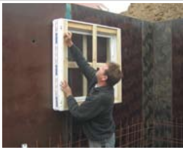
Holzabstützung für innen anbringen
