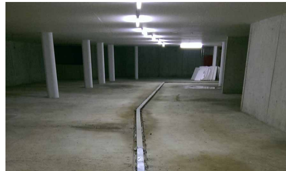
Anwendungsbeispiel 2 Montage in vorhandene Aussparung
