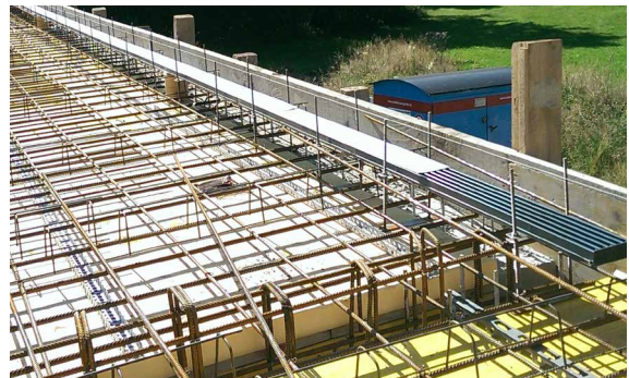
Anwendungsbeispiel 1 Montage mit Rinnenaufständerung
