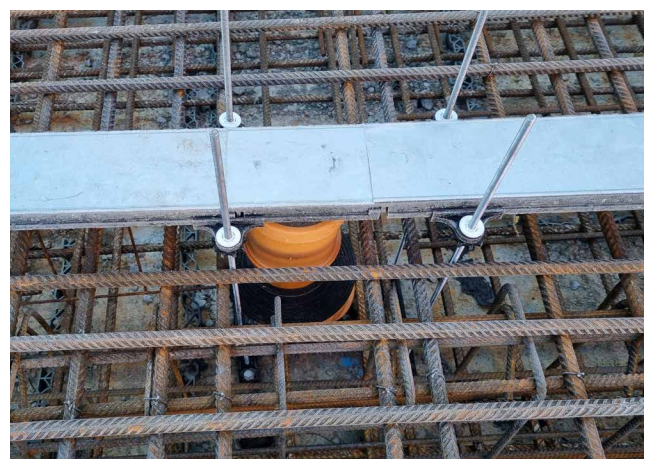
Sicherungen anbringen und Gewindestangen kürzen. Montageabdeckblech anbringen.
