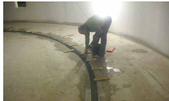
Anwendungsbeispiel 2 Montage in vorhandene Aussparung
