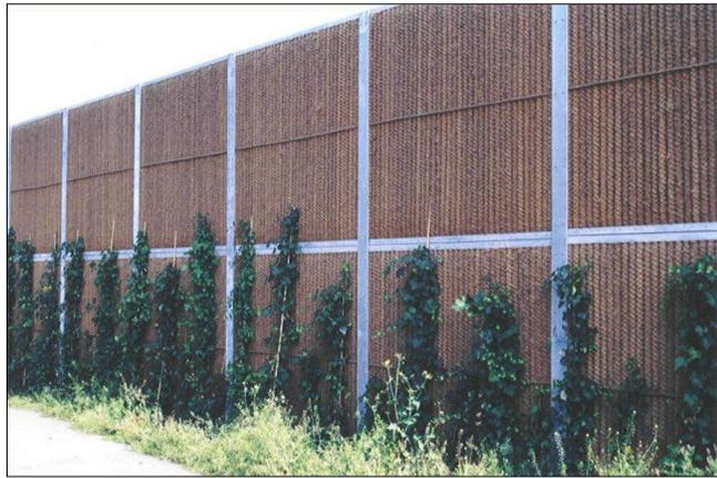
Der Aufbau erfolgt innerhalb kurzer Zeit nach dem Baukastenprinzip. Die bereits vorgefertigten Elemente werden zwischen eine Stahlkonstruktion aus IP-E bzw. HE-A Stützpfeuern montiert. Danach können an beiden Seiten der Wand Kletterpflanzen gesetzt werden.
