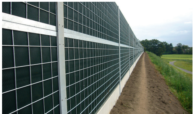
Lärmschutzwand Noise reducer HA
