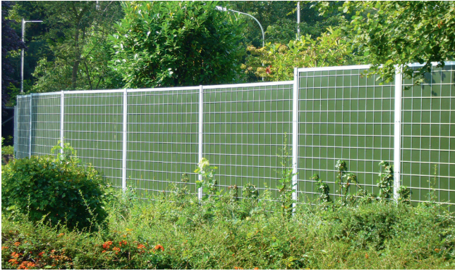
Lärmschutzwand Noise reducer HA
