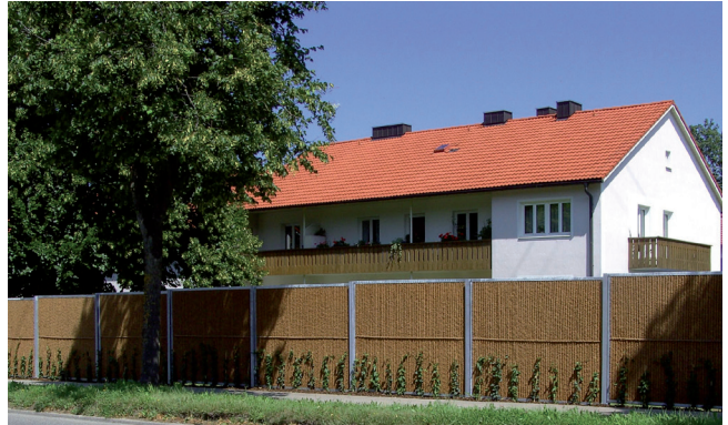
Lärmschutzwand Koko wall
