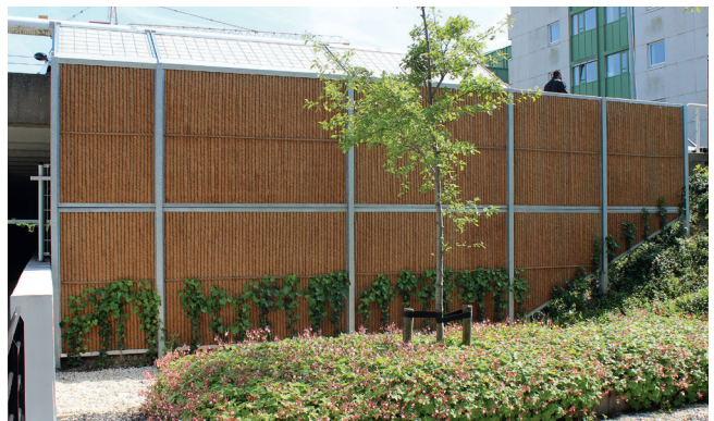
Lärmschutzwand Koko wall HA
