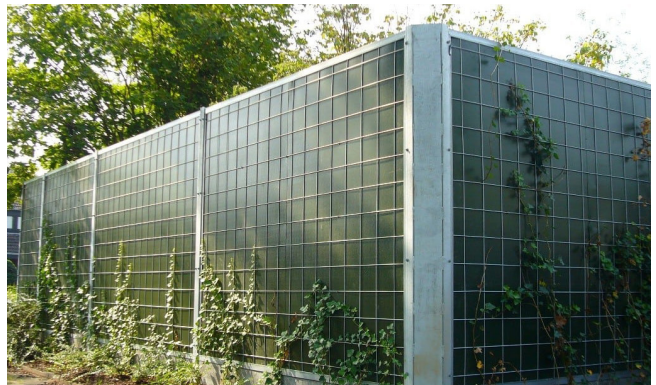
Lärmschutzwand Noise reducer
