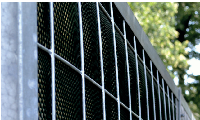
Lärmschutzwand Noise reducer
