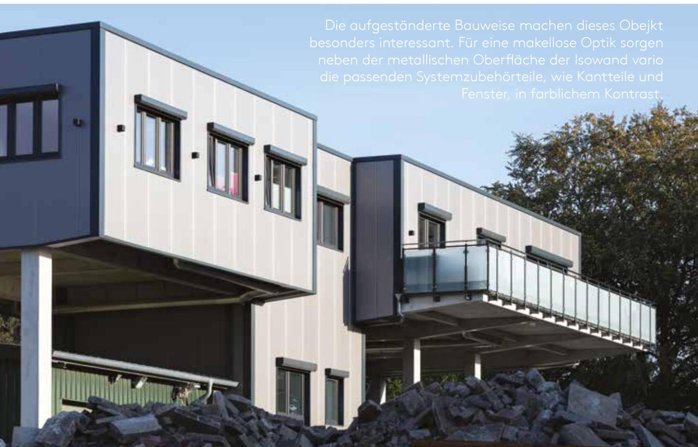
Die aufgeständerte Bauweise macht dieses Objekt besonders interessant. Für eine makellose Optik sorgen neben der metallischen Oberfläche der Isowand vario die passenden Systemzubehörteile, wie Kantelemente und Fenster, in farbllichem Kontrast.
