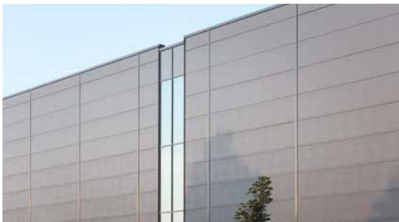
Mit einem Lamba-Wert von 0,019 W/mK sorgen Sandwichpaneele mit der innovativen Dämmkern-Technologie für hohe Energieeffizienz und einen schlanken Wandaufbau.
