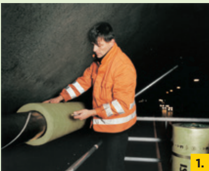
1. Schritt: U TECH Pipe Section MT 4.0 gemäß DIN 4140 fixieren.
