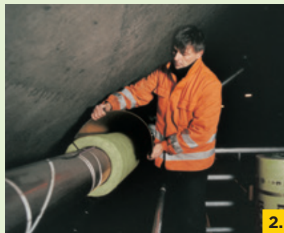
2. Schritt: Bei Bedarf anschließend Blechmantel als Schutz vor Witterungseinflüssen aufbringen.
