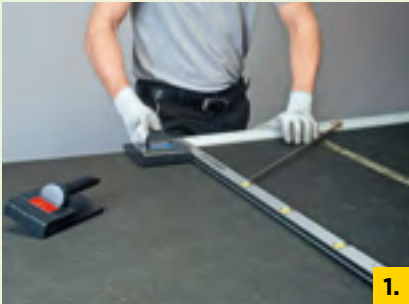
1. Stufenfalz mit CLIMAVER® Werkzeugen herstellen
