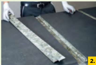
2. Verbleibende Dämmstoffstreifen entfernen
