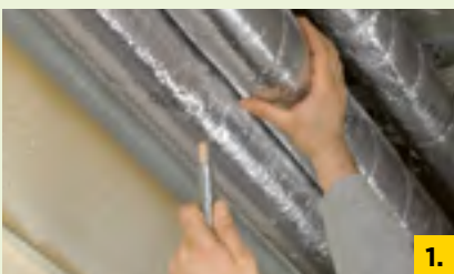
1. Fixieren Sie die U Protect Pipe Section Alu2 Rohrschale gemäß Prüfzeugnis.
