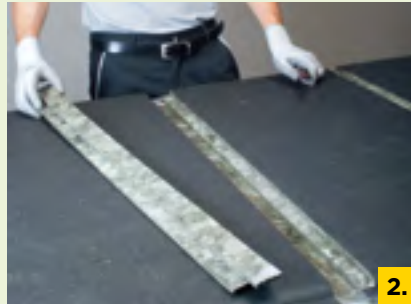
2. Verbleibende Dämmstoffstreifen entfernen
