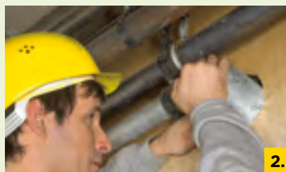
2. Vorteil: kein Produktwechsel. Verlegen Sie die U Protect Pipe Section Alu2 Rohrschale gemäß Prüfzeugnis, auch im Durchbruch.
