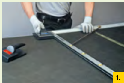
1. Stufenfalz mit CLIMAVER® Werkzeugen herstellen
