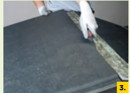
3. Wiederverwendbare Plattenreste abtrennen
