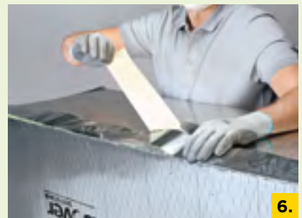
7. Stoß mit CLIMAVER® Klebeband luftdicht verkleben
