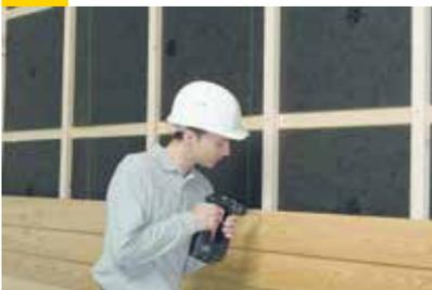
Ab einem Fugenanteil von mehr als 5 % ist eine Fassadenbahn vorzusehen. In diesem Fall werden die Rahmenhölzer in ganzer Tiefe ausgedämmt. Nach der Montage der Fassadebahn werden vertikale Latten für die Be- und Enlüftungsebene angebracht.
