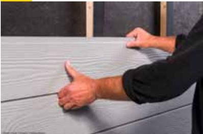
Vor Montage der Fassadenbekleidung, werden die Rahmenhölzer mit einer Trennschicht (z.B. EPDM Band) geschützt. Dies gilt auch für Außenecken und Fensterlaibungen. Das Band wird von oben nach unten angebracht. Nun kann die Fassadenbekleidung montiert werden. Die Verlegehinweise des Fassadenbekleidung-Herstellers sind zu beachten.
