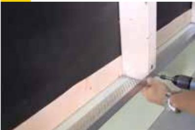
Um eine einwandfreie Funktion der Be- und Enlüftungsebene zu gewährleisten, sind im Sockelbereich und am Dachrand die Entlüftungsöffnungen mit mindestens  $50 \text{ cm}^2$  je 1 m Wandlänge vorzusehen. Ist die Tiefe der Be- und Enlüftungsebene größer als 20 mm müssen die Öffnungen im Sockelbereich durch Lüftungsgitter gesichert werden.
