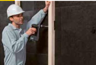
Je nach Untergrund sind die Rahmenhölzer mit geeigneten Befestigungsmitteln zu montieren. Wichtig ist darauf zu achten, dass die Unterkonstruktion eben und gerade angebracht wird. Die statischen Anforderungen sind zu berücksichtigen. Bei Bedarf zeichnet man die horizontale Grundlinie für den Sockel. Ein Laser und/oder eine Schlagschnur sind hier hilfreich. An Stellen, an denen später Gegenstände befestigt werden (z.B. Briefkästen), sind zusätzliche vertikale Holzlaten vorzusehen.
