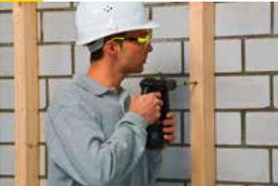
Die vertikalen Rahmenhölzer der Unterkonstruktion müssen mindestens 20 mm höher als die Dämmstoffdicke sein, um den geforderten Hinterlüftungsquerschnitt zu ermöglichen. Mit einer Schlagschnur kann die Wand in gleichmäßige Abschnitte eingeteilt werden. Um eine lückenlose Verlegung der Dämmung zu gewährleisten sollte der lichte Abstand zwischen den Rahmenhölzern 2-3 mm geringer als die Breite der Kontur FSP Fassaden-Dämmplatten sein.
