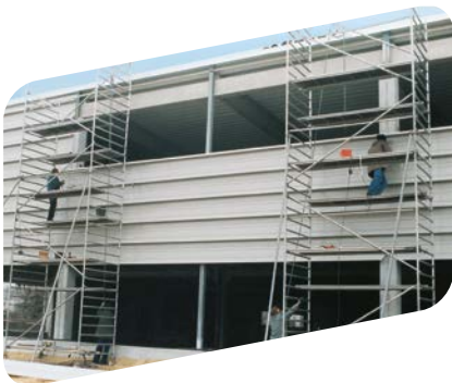
Leere Stahlkassetten vor der Dämmstoffverlegung
