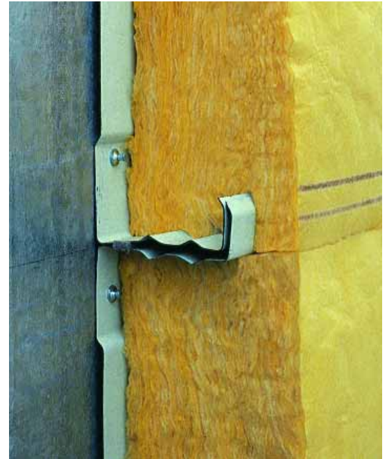
ISOVER Metac WS dämmt nach oben und nach unten gerichtete Kassettenurte gleichermaßen gut.
