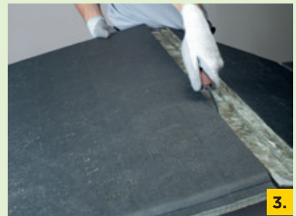
3. Wiederverwendbare Plattenreste abtrennen
