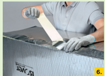
6. Stoß mit CLIMAVER® Klebeband luftdicht verkleben
