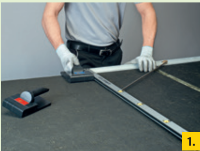
1. Stufenfalz mit CLIMAVER® Werkzeugen herstellen
