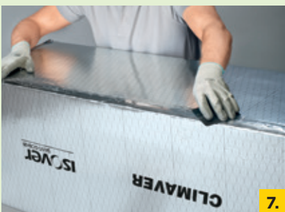
7. Klebeband anpressen – fertig ist das Kanalsegment
