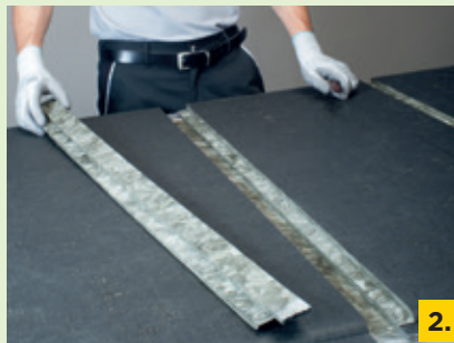
2. Verbleibende Dämmstoffstreifen entfernen
