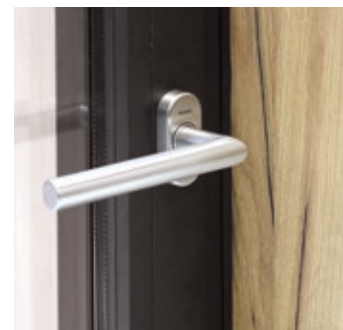
Mikro-Lüftung (90°) Schiebeflügel noch verriegelt
