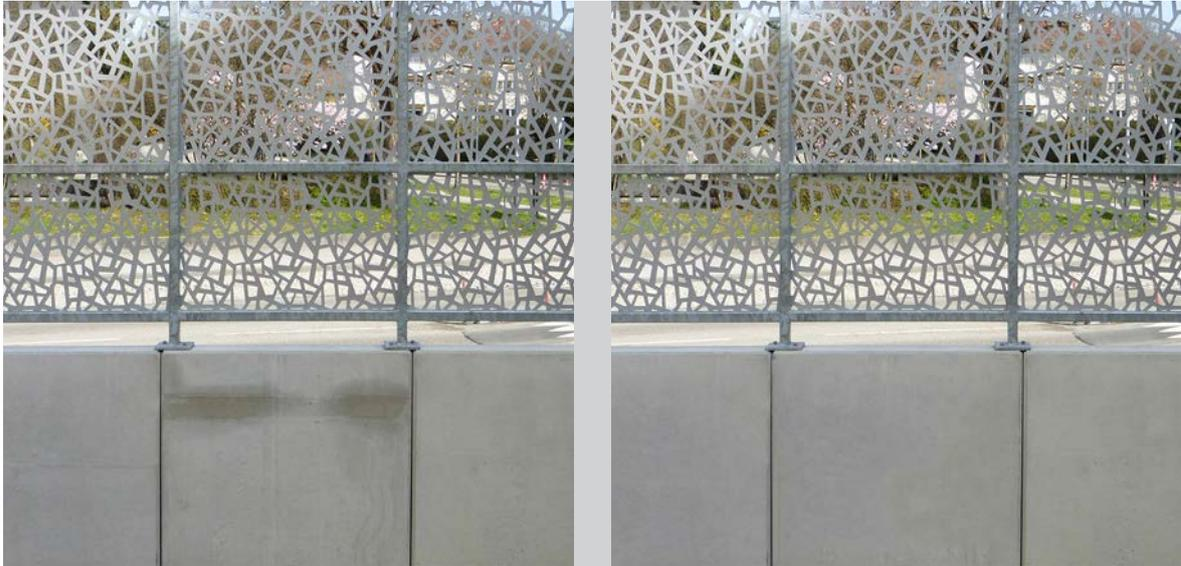
Sichtbetonoptimierung in drei Schritten: 1. Schonende Reinigung ohne Materialabtrag, 2. Vollflächige Lasur zur farblichen Angleichung, 3. Partielle Retusche mit Angleichung an Umgebungsfarbtönen (© OptiBeton)
