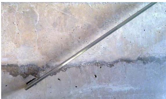
Neubeton mit Betonierfehlern, die nachgespachtelt werden müssen
