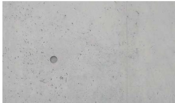
Gleichmäßige mineralische KEIM Concretal-Lasur Oberfläche
