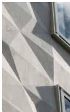
**Verolith® kann mittels CNC-Fräse bearbeitet werden und bietet völlig neue Möglichkeiten zur individuellen und plastischen Gestaltung von Fassaden.**
