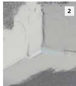
2 Sto-Tropfkantenprofil an das Eckstück anschließen und in den Unterputz einbetten.
