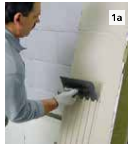
Sto-Steinwolleplatte Wärmedämmplatte aus Mineralwolle nach DIN EN 13162
