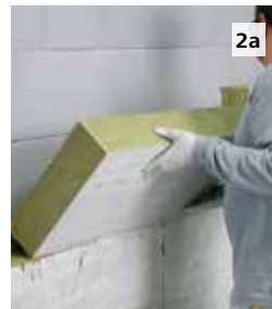
Lamellendämmplatte aus Mineralwolle Wärmedämmplatte aus Mineralwolle nach DIN EN 13162; Hohe Abreißfestigkeit durch senkrecht stehende Fasern
