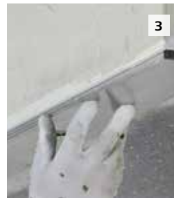
3 Sto-Tropfkantenprofil ausrichten.
