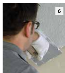
6 Nach Durchtrocknung des Unterputzes Zwischenbeschichtung (ggf. nicht bei StoTherm Classic®) und Oberputz auftragen. Überstehenden Oberputz an den Kanten abziehen.
