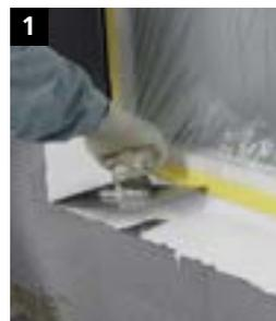
**1** StoFlexyl mit StoFlexyl Cement im Verhältnis 1:1 anmischen und mit max. 10 % Wasser verdünnen. Die erste Lage StoFlexyl-Zementgemisch auf die armierte Fensterlaibung aufbringen und trocknen lassen. Anschließend die zweite Lage StoFlexyl-Zementgemisch aufbringen und erneut trocknen lassen.
