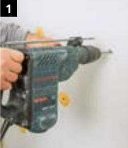
1 Die benötigten Bohrlöcher in die Wand bohren. Dabei die entsprechenden Hinweise des Technischen Merkblatts und der Zulassungen beachten.
