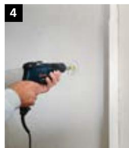
Beispiel einer Randverdübelung durch den bewehrten Unterputz im Bereich einer Gebäudetrennfuge
