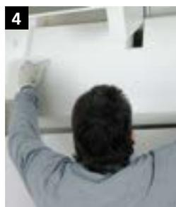
**4** Kleber vollflächig auf die Dämmplatten auftragen. Dämmplatten einsetzen und press gestoßen verlegen. Aus handwerklichen Gründen muss unterhalb der Passstücke immer ein Bereich ausgespart werden. In diesen später (nach Verlegung der obersten Plattenreihe) den Dämmstoff einpassen.
