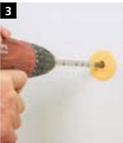
3 Die Dübelschraube eindrehen, sodass der Dübelteller bündig mit der Dämmstoffoberfläche ist.
