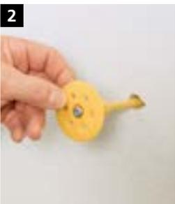
2 Den Dübel weit in das Bohrloch einstecken, bis der Dübelteller bündig auf der Dämmplatte sitzt.
