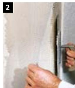
Die Dämmplatten werden nun bis zum offenen Systemende über das vorgelegte Gewebe aufgeklebt. Der Klebeflächenanteil (Kontaktfläche) von  $\geq 70\%$  ist dabei unbedingt einzuhalten.
