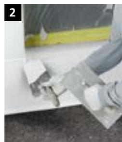
**2** Auf der ausgehärteten Dichtwanne mit dem StoFlexyl-Zementgemisch mehrere Klebewulste aufbringen. Dadurch kann das eindringende Wasser ablaufen.
