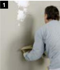
1 Den Unterputz mit der Traufel in einer Breite von 110 bis 120 cm volldeckend auftragen.
