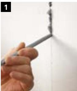
**1** Unvermeidbare Fugen zwischen den Dämmplatten müssen mit Sto-Pistolen-schaum SE geschlossen werden. Den Füllschaum nach Trocknung planeben abschneiden. Fugen über 5 mm Breite sind mit artgleichem Dämmstoff zu schließen.
