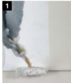
1 Nach Durchtrocknung des Unterputzes ggf. den pigmentierten Voranstrich (StoPrep Miral) mit einer Walze vollflächig auf die Armierung auftragen.
