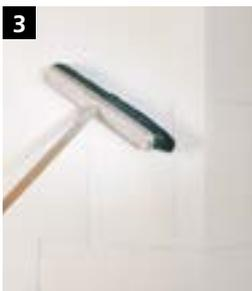
**3** Der Schleifstaub ist z. B. mit einem weichen Besen zu entfernen.
