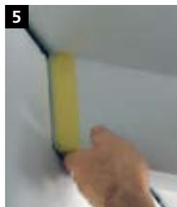
**5** Die Dachsparren umlaufend mit Klebeband abkleben.
