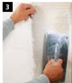
Nach dem Verkleben der Dämmplatten wird das Sto-Glasfasergewebe an der Dämmplattenstirnseite und auf der Dämmplattenfläche in den Unterputz eingebettet. Anschließend wird die Fläche mit Unterputz versehen.
