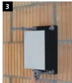
**3** Die Schraubdübel einsetzen und anziehen, bis die Montageplatte in der äußeren Dämmplattenflucht bündig positioniert ist. Die Eignung der mitgelieferten Schraubdübel muss für den vorliegenden Untergrund überprüft werden.
