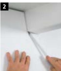
**2** Zugeschnittene Dämmplatten erneut ansetzen und die Vorderkante an der Dachuntersicht und den Sparren anzeichnen.
