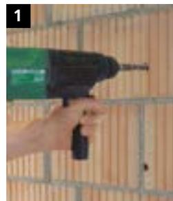
**1** Bohrlöcher anzeichnen und von Bohrstaub befreien. Bei Mauerwerk mit Lochsteinen ohne Schlag bohren.
