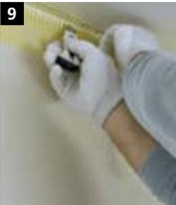
9 Im Rahmen der Flächenarmierung Sto-Glasfasergewebe an den Sparren ansetzen und die Sparren ausschneiden. Überstehendes Gewebe an den Sparren und Attikaprofilen abschneiden. Gewebe anschließend in den feuchten Unterputz einbetten.
