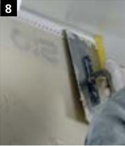
8 Sto-Attikaprofile mit etwas Abstand zum Dachanschluss ansetzen und in den feuchten Unterputz einbetten.
