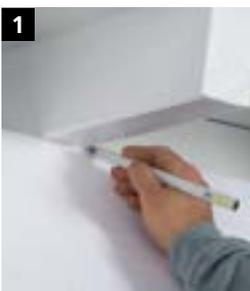
**1** Schräg geschnittene Dämmplatten entsprechend der Dachschräge vorbereiten. Die vorbereiteten Dämmplatten ansetzen und die Dachsparren anzeichnen. Anschließend die Dämmplatten passgenau zuschneiden.
