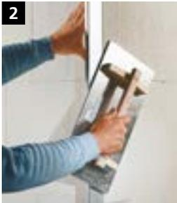
**2** Dämmplatten planeben schleifen. Zum Schleifen der Ecken und Kanten Anschlaglatte benutzen.
