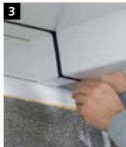
**3** Zur Abdichtung der Anschlussfuge Sto-Fugendichtband Lento durchgehend und bündig von innen an die angezeichnete Dämmplattenvorderkante kleben.
