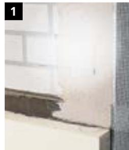
Am offenen Systemende wird ca. 20 cm breit Klebemörtel auf den Untergrund vorgelegt, in den das Sto-Glasfasergewebe eingebettet wird. Zum freien Rand steht das Gewebe um weitere ca. 20 cm plus der Dämmplattendicke über.
