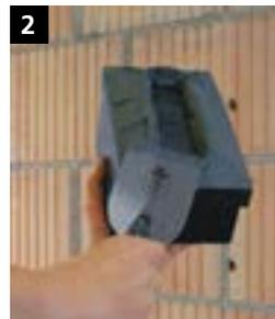
**2** Sto-Klebemörtel auf die Klebefläche der Montageplatte aufziehen. Die Klebefläche vollflächig (ca. 5 mm Schichtdicke) auf dem tragfähigen Untergrund verkleben.
