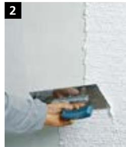
2 Nach Durchtrocknung der Zwischenbeschichtung/des Unterputzes erfolgt die Verarbeitung des Oberputzes nass in nass. Die Flächen müssen ansatzlos beschichtet werden.
