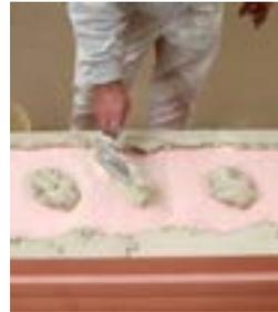
Die Klebefläche/Kontaktfläche muss nach bauaufsichtlicher Zulassung mind. 60 % betragen.
