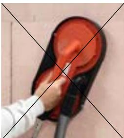
Das Abschleifen der Sto-Resol-Dämmplatte ist grundsätzlich nicht möglich.
