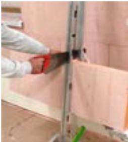
Die Sto-Resol-Dämmplatte besteht aus Phenolharz-Hartschaum. Bei diesem Material handelt es sich um ein sogenanntes Duroplast. Das heißt, bei Erwärmung findet kein Schmelzen statt. Dadurch ist das Schneiden mit einem Heißdraht nicht möglich. Sto empfiehlt die Verwendung einer Säge bzw. eines Minerschneidegerätes.
