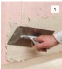
Im Bereich der Dämmplattenkante Armierungsmasse in der Breite des Profils und des Gewebestreifens auftragen.
