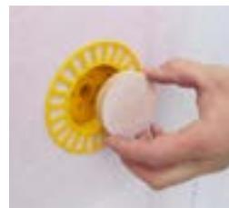
Eine versenkte Montage des Dübels ist mit Sto-Dübelversenkter und Sto-Thermodübel II UEZ 8/60 möglich.
