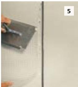
Das Armierungsgewebe vollflächig in die Armierungsmasse einbetten.
