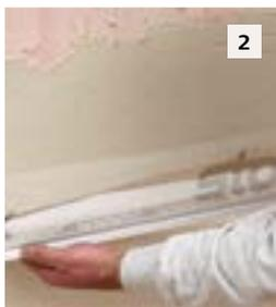
Den waagrechten Schenkel des Sto-Sockelprofils PH zwischen Sockel- und Fassadendämmung stecken. Den gelochten Schenkel und das Glasfasergewebe in die frische Armierungsmasse einspachteln. Zur Verbindung der Profile wird der Sto-Sockelleistenverbinder L verwendet. Dieser wird bedarfsgerecht zugeschnitten.
